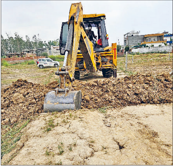
अंबाला। अवैध कॉलोनियों में निर्माण को ढहाती जेसीबी।
