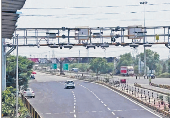
करनाल। बस्ताड़ा टोल प्लाजा पर शुरू की गई मल्टी लेन फ्री फ्लो प्रणाली के तहत लगाए गए अत्याधुनिक कैमरे और सेंसर।
